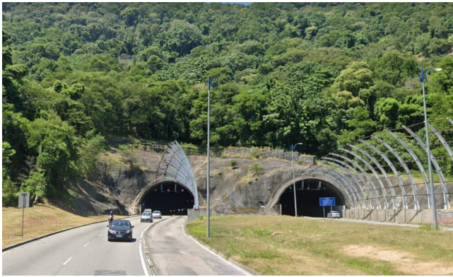
Túnel da Grota Funda
