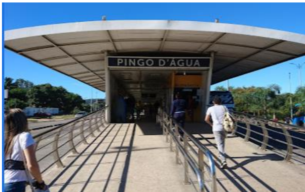
Estação do BRT- Av. Dom João VI/Estr. da Pedra
